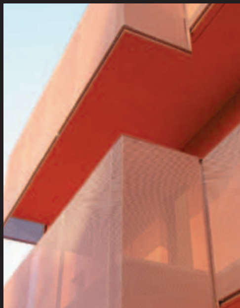
Mesh: DL 16 x DC 8 - av 3 x sp 1.5mm - Painted Sendzimir carbon steel
