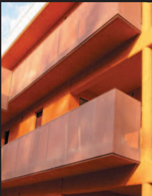
Mesh: DL 16 x DC 8 - av 3 x sp 1.5mm - Painted Sendzimir carbon steel
