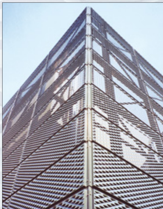
AMBASCIATA - DL 110 x DC 40 (52) - av 24 x sp 2 mm Hot dip galvanised steel
