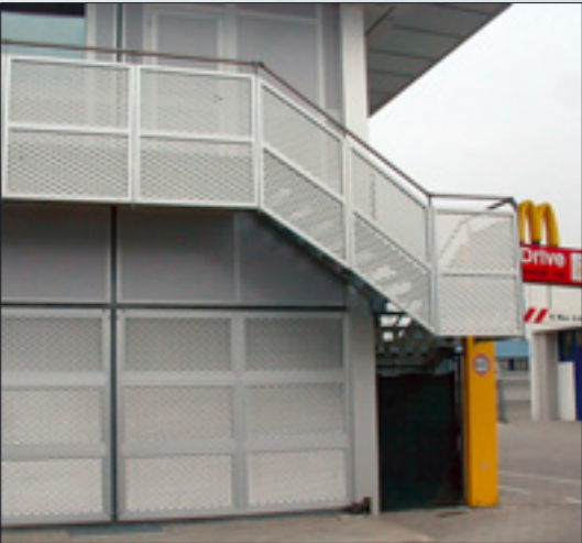
AMBASCIATA - DL 110 x DC 40 (52) - av 24 x sp 1.5 mm Natural anodised aluminium
