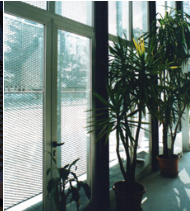
GATE - DL 76 x DC 31 (35) - av 11 x sp 2 mm Hot dip galvanised steel
