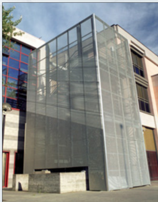
AIRPORT - DL 62,5 x DC 20 (25.5) - av 9.1 x sp 1.5 mm Natural anodised aluminium
