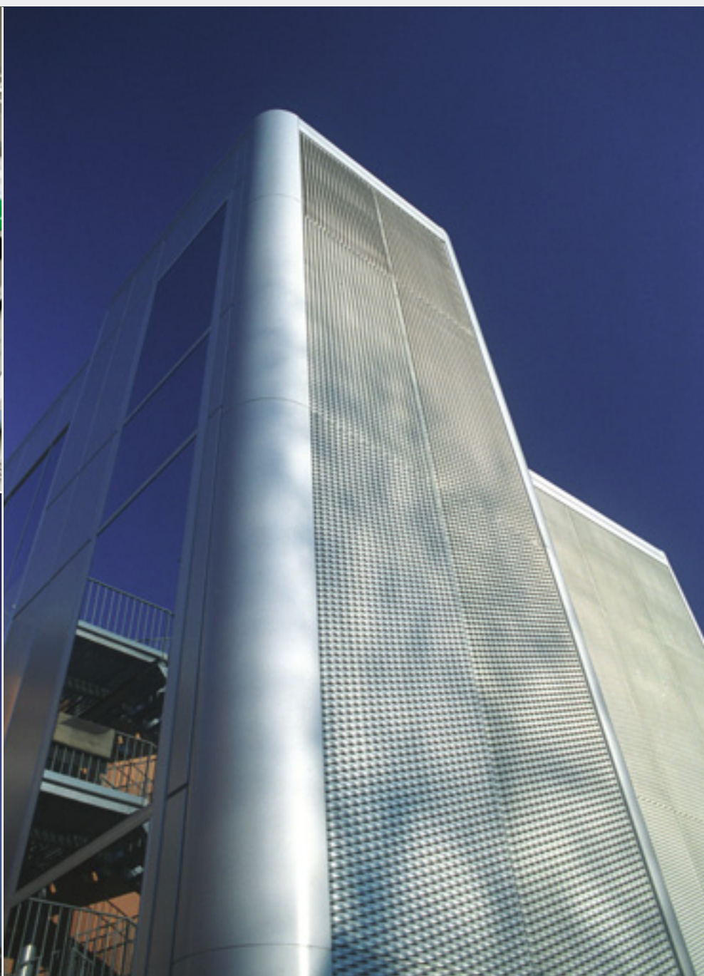
RESERVE - DL 90 x DC 30 (38) - av 18 x sp 1.5 mm Natural anodised aluminium
