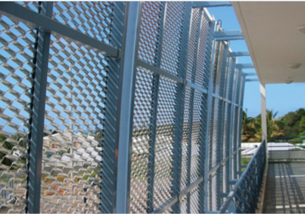
COLISEUM - DL 200 x DC 75 (80) - av 24 x sp 2 mm Aluminium
