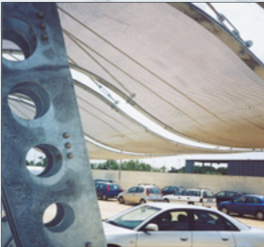
FILS 20 - DL 45 x DC 15 (11.4) - av 3.3 x sp 2 mm AISI 304 steel
