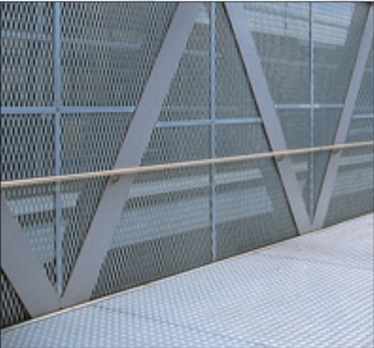
SP 2 - DL 110 x DC 40 (41.6) - av 9.5 x sp 4 mm Hot dip galvanised steel
