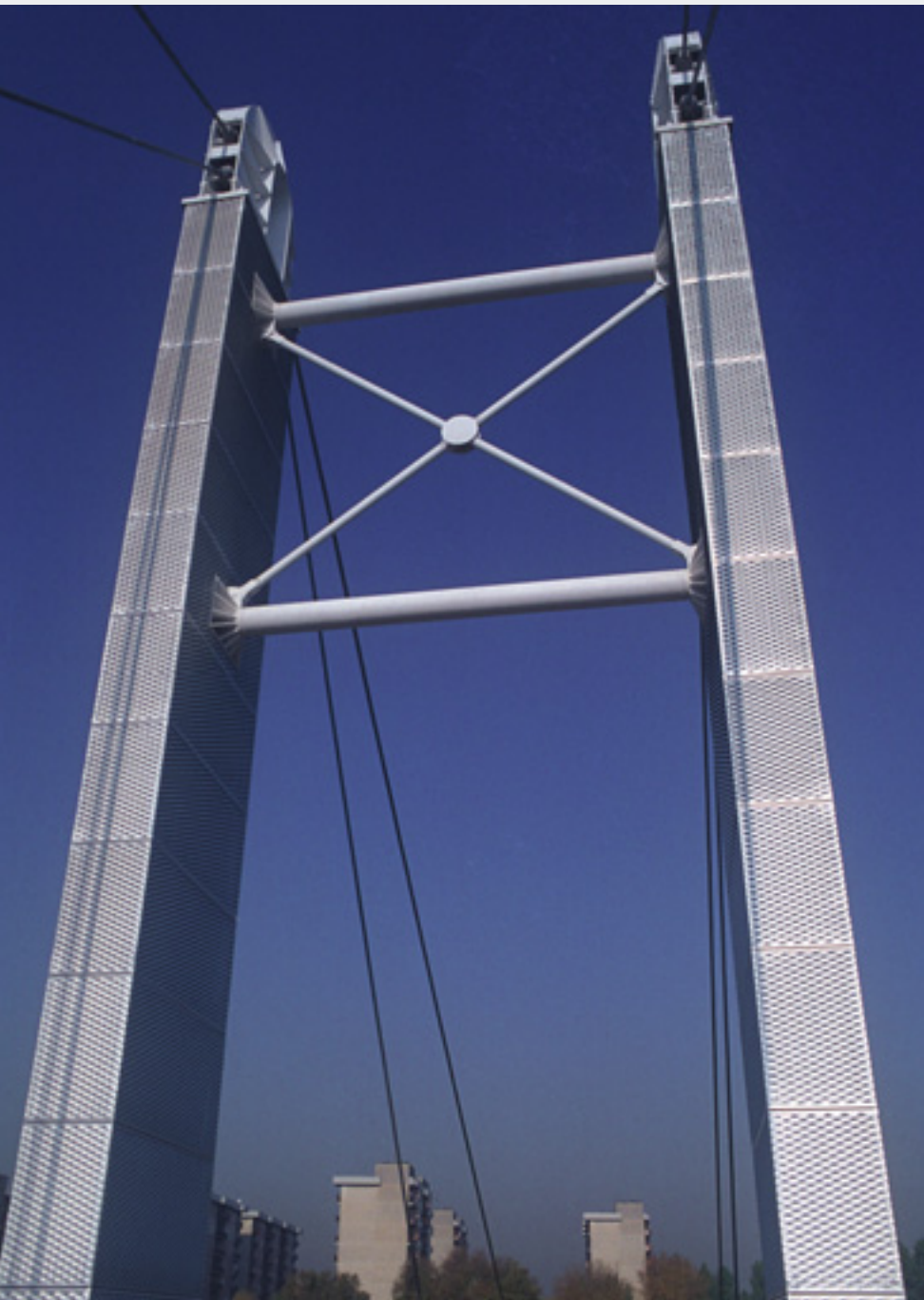
ACADEMY - DL 115 x DC 40 (48) - av 20 x sp 1.5 mm Natural anodised aluminium
